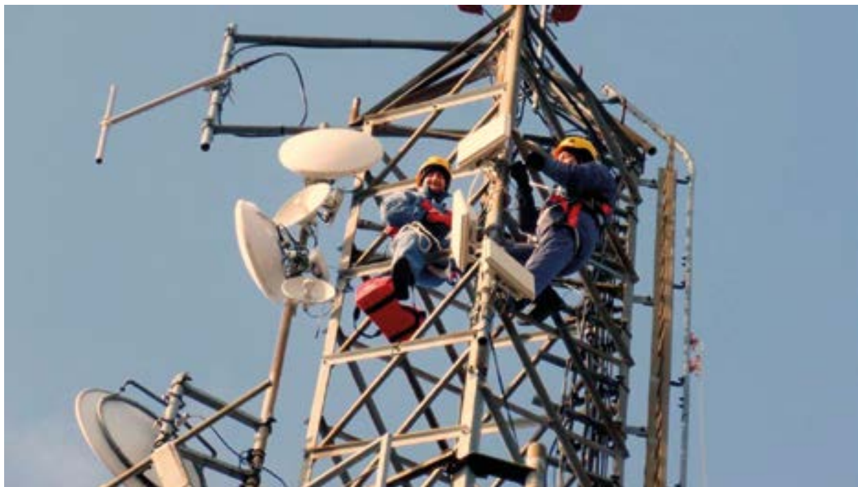
Tehniki službe telekomunikacij med pregledom antenske opreme na oddajniškem stolpu Avtor: Davor Lipej
