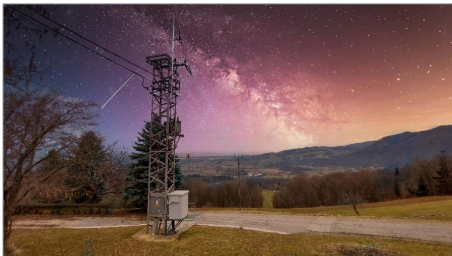
Repetitor za radijski sistem Kostanjevica, nameščen v sklopu TP Male Vodenice nad Kostanjevico
